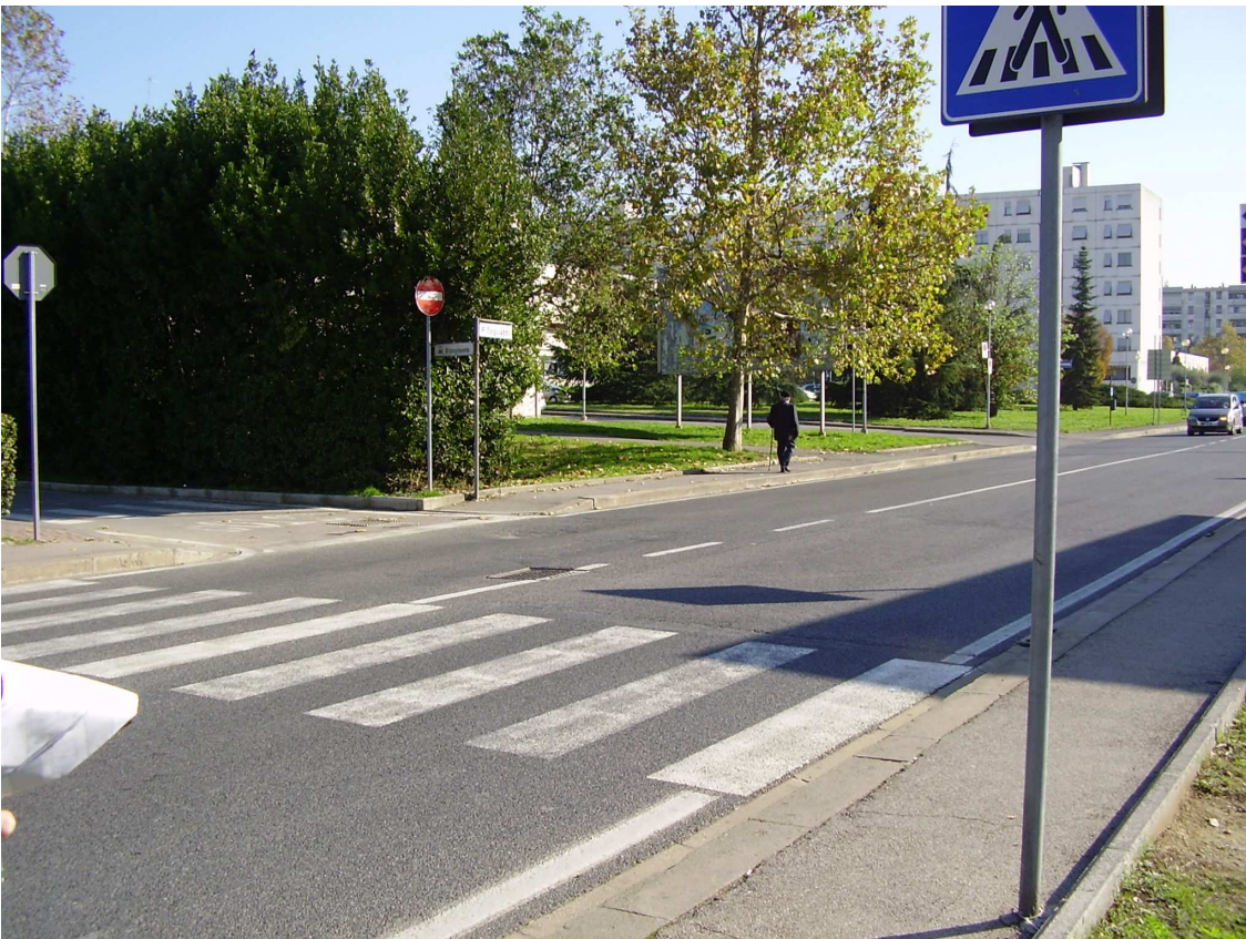
Foto 4: Vista incrocio Viale Togliatti -Via del Risorgimento tratto nord
